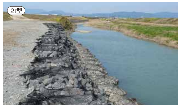
2t型 佐田川下古賀地区応急対策工事
