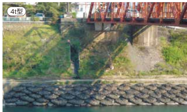
4t型 坂本地区災害復旧工事
