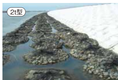
2t型 横田中流部低水護岸工事
