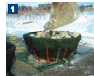
1 製作用型枠内にE-UNITを設置し、中詰め材を投入します。
