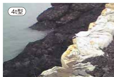
4t型 東通原子力発電所1号機 新設に伴う港湾工事
