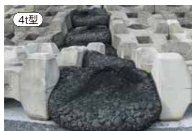
4t型 平成25年度 大井川管内堤防維持管理工事
