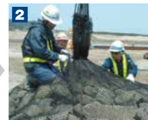
2 中詰め材投入後、口縛りローブを結束します。
