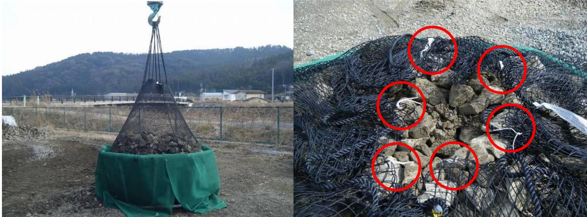
白紐の目印より、吊りロープを引き出し、仮吊りを行い、ロープ、網地の長さを揃えます。
