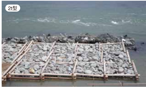
阿武隈川伏黒管内下流地区河川維持工事
