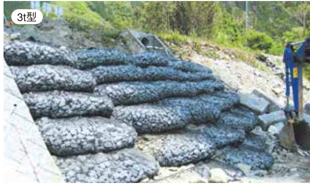
平成25年度二級河川興津川河川維持修繕工事
