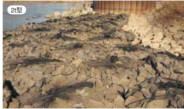
阿武隈川伏黒管内河川構造物補修工事
