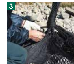
③ スーパーE-ユニットの口縛りを行います。
