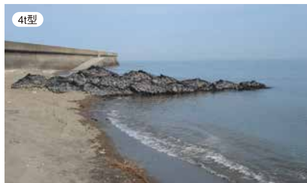
平成23年度港建中第1号港湾改良工事
