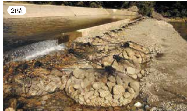
都田灌漑排水整備その2工事
