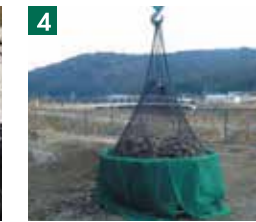
④ 製作型枠からスーパーE-ユニットをクレーン等で吊り上げます。
