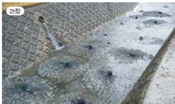
平成23年度 二級河川鮎沢川外河川維持修繕工事
