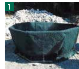
① 製作型枠にスーパーE-ユニットを設置します。
