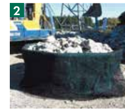
② スーパーE-ユニットに中詰め材の充填します。
