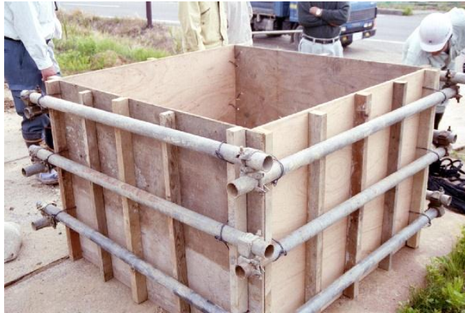
①コンパネ+単管タイプで枠組みします。
