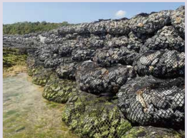
● 沖縄県 仮設道路として使用
