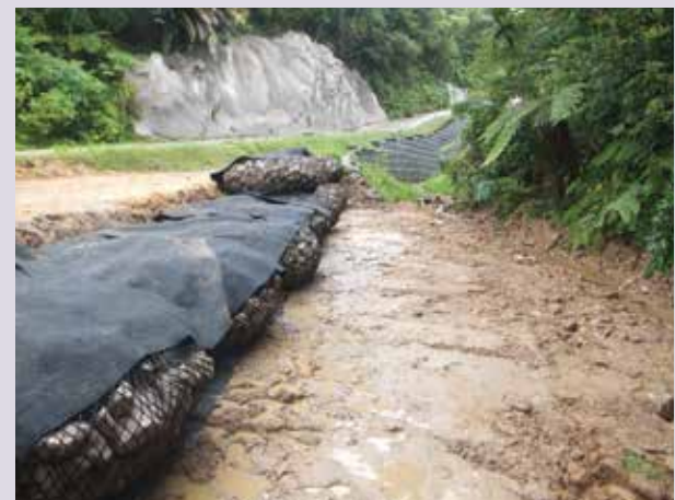
● 沖縄県 洗掘防止工として使用
