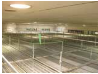
① 足場を組み立てます。
